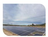
Instalación de autoconsumo acogida a venta de excedentes donde se ha programado un autómata que detecta el paso de nubes mediante un algoritmo que permite evitar falsos arranques a la bomba sumergida de extracción de agua de 400 CV. Este autómata tiene en consideración la radiación solar y el coste energético,
